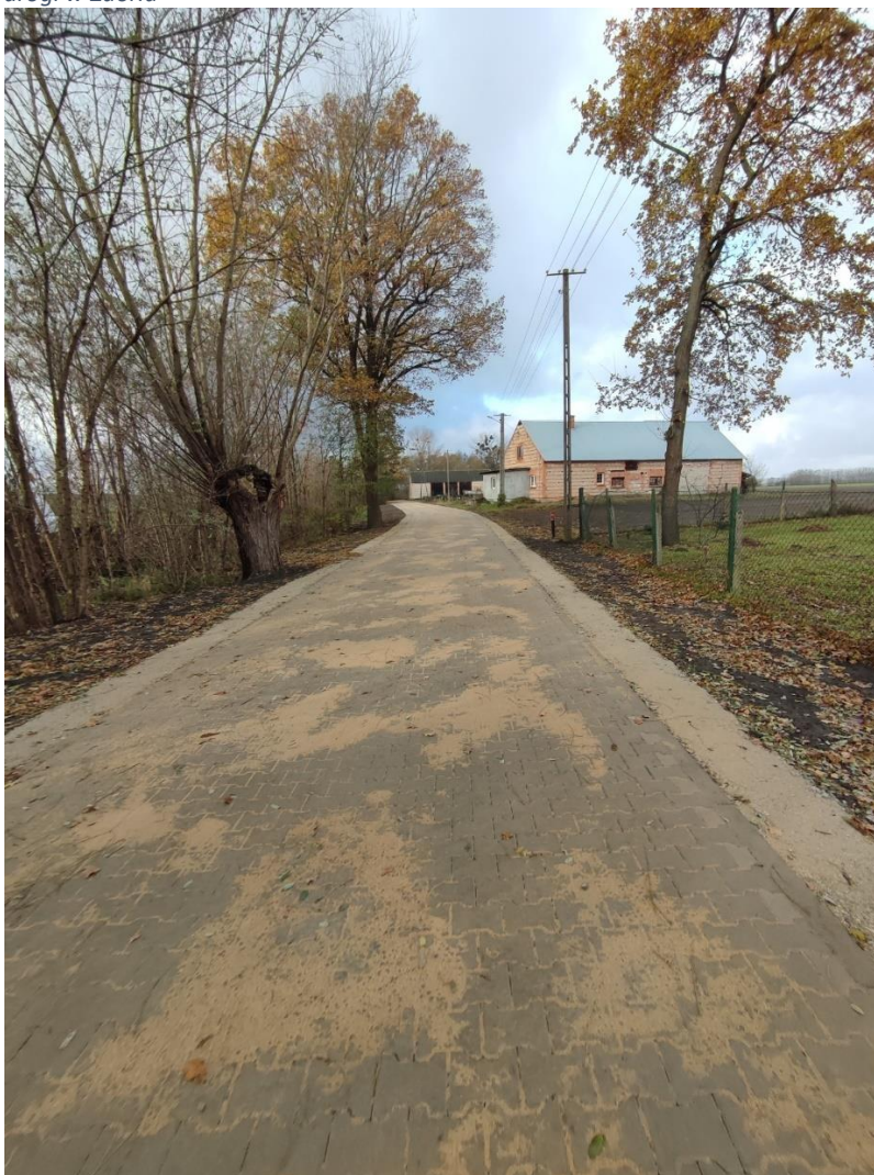
Ilustracja 2: budowa drogi w Zaorlu
