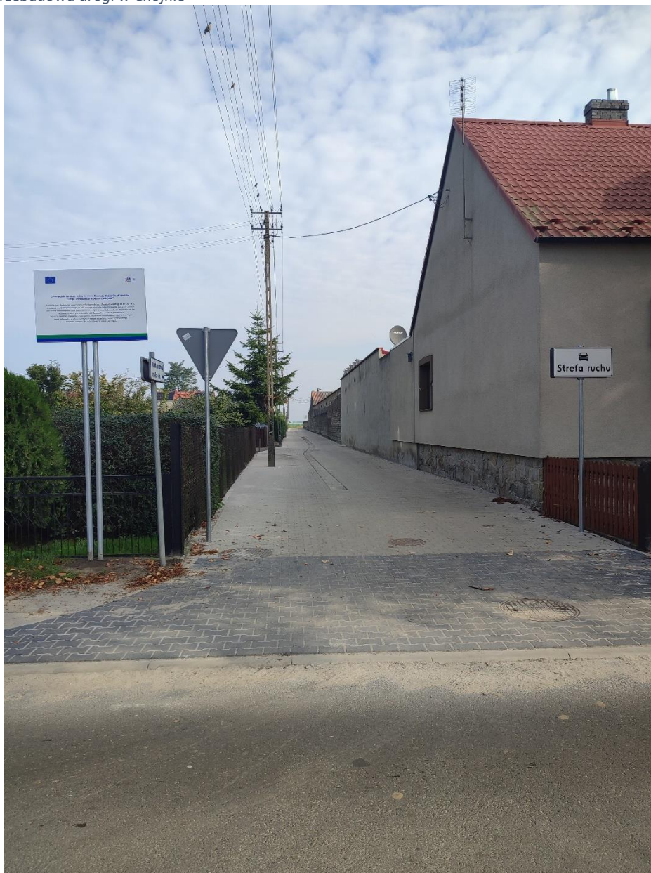
Ilustracja 6: przebudowa drogi w Chojnie
