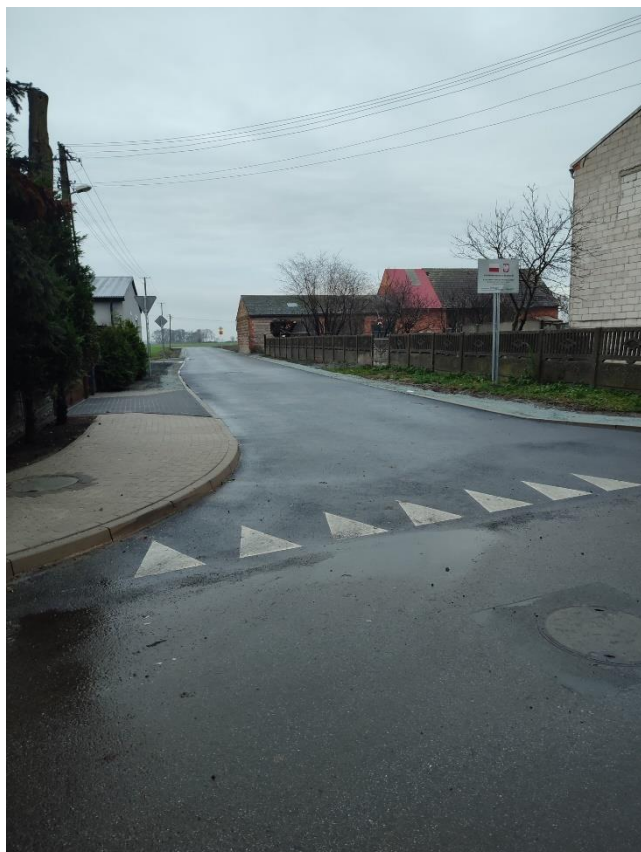
Ilustracja 4: budowa drogi w Góreczkach Wielkich
