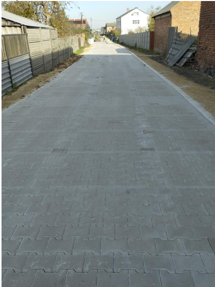
Ilustracja 5: budowa drogi w Ostrobudkach
